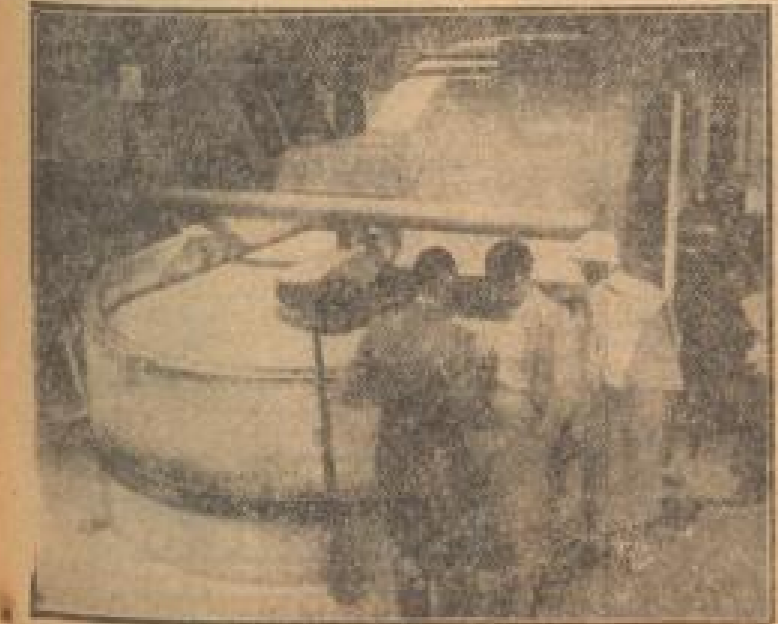
Ein Mischholländer (Mischung von Holzschliff, Zellstoff usw.)
