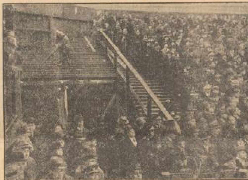
Während eines Spieles auf dem Platz des Prager Fußballplatzes „Slavia“ brach ein Teil des Hauptbaus der Tribünen ein. Die Zuschauer wurden durch die Trümmer verletzt. Die Katastrophe ereignete sich am 2. Dezember 1934.
