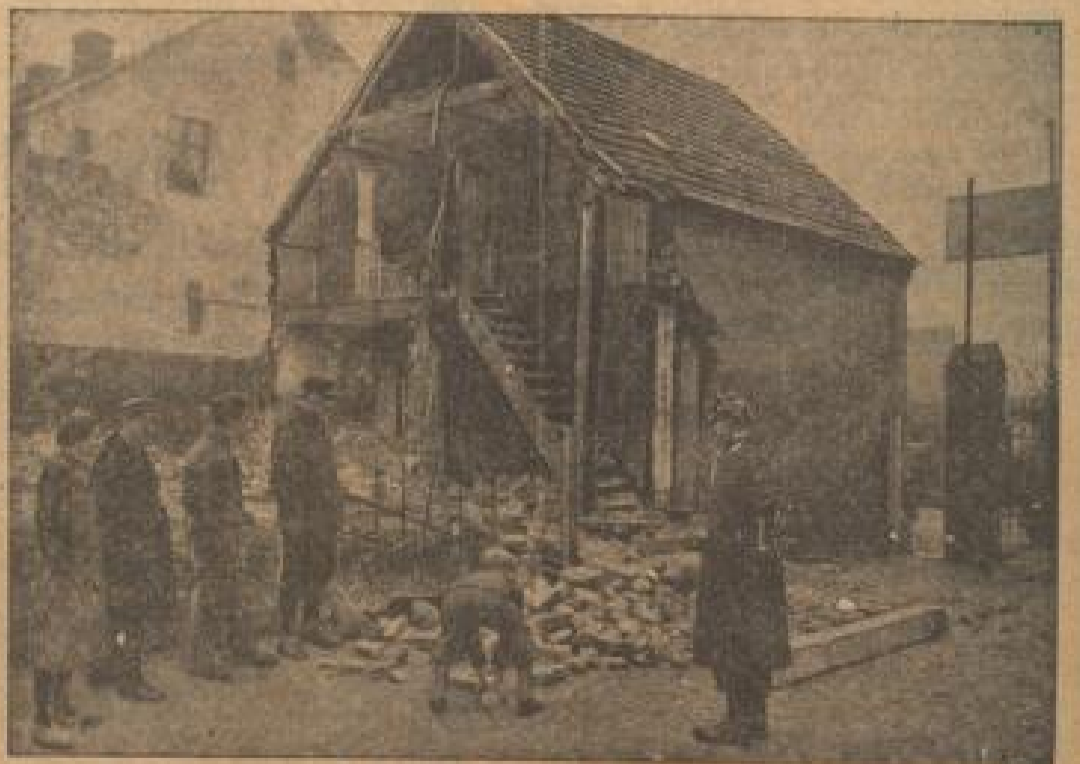
Der eingestürzte Giebel eines Bauernhauses in Brigh bei Berlin. Die ganze Seitenwand des Gebäudes ist in sich zusammengebrochen, wie in einem Augenblick ist man im Bild in die innere Wohnkammer. Die Ursache dieses Einsturzes lag, bei dem die Bewohner nie durch ein Wunder ohne Verletzungen davongekommen, liegt in den Verhältnissen, denen das Gebäude durch den starken Straßendruck ausgesetzt war.
