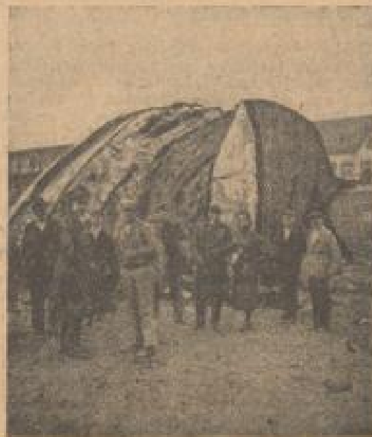
Die Trümmer des Behälters nach der Sprengung
