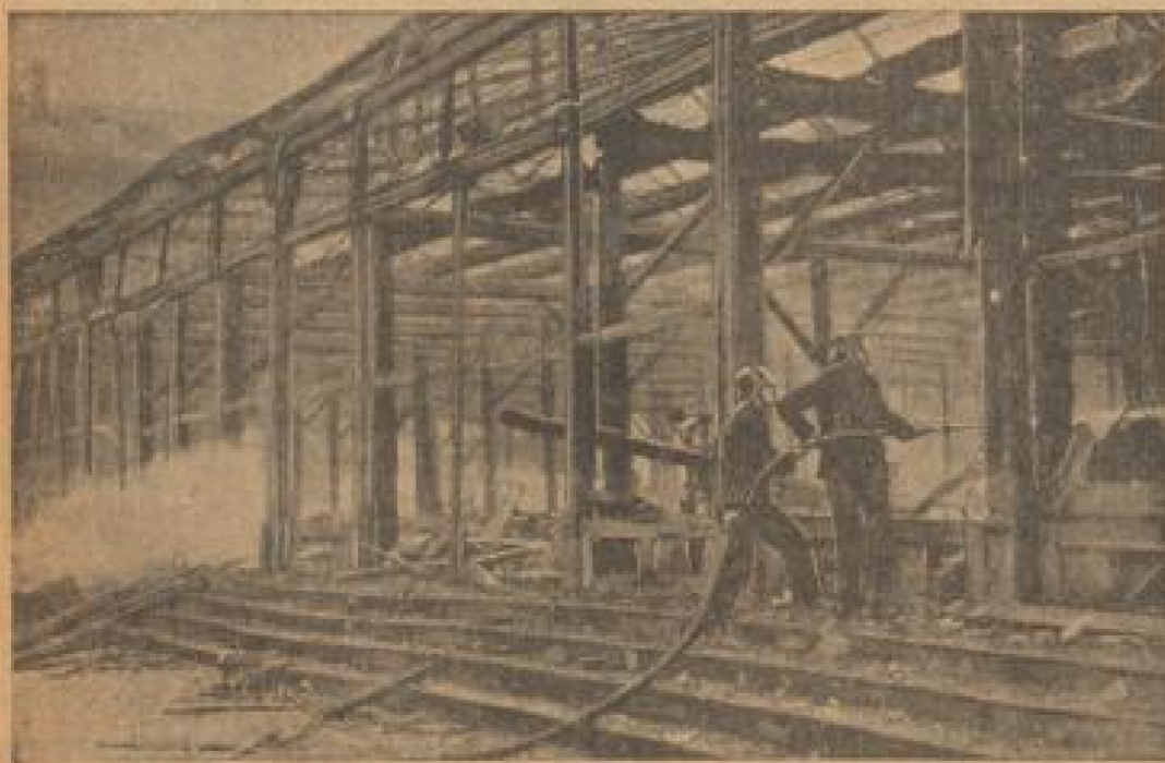
Feuerwehrlente beim Abbau der Brandruine
