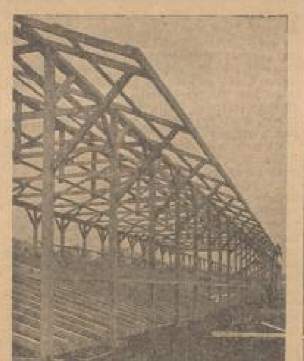
Das Gerippe der Sitztribüne des Vorführungsringes.
