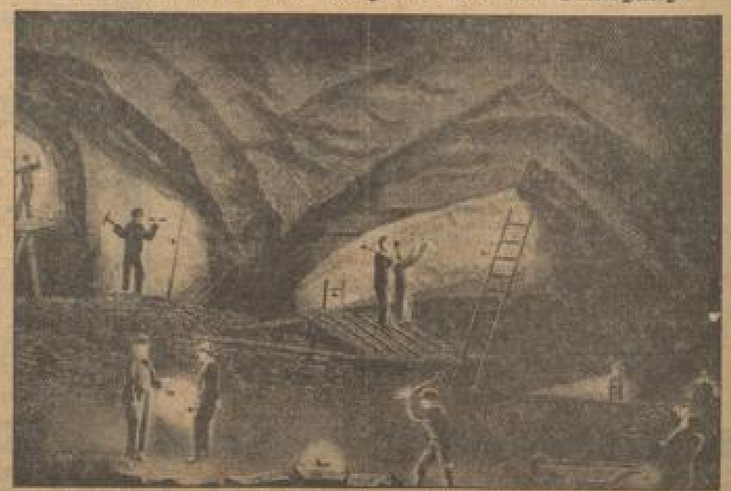
Alle Darstellung von Bohrarbeiten in dem Rammelsberger Erzbergwerk, das mehr als 1000 Jahre alt ist und fast geschlossen werden soll. Die Darstellung wurde für die Wittenbergische Bergbau-Gesellschaft als Gedenkstück angefertigt.
