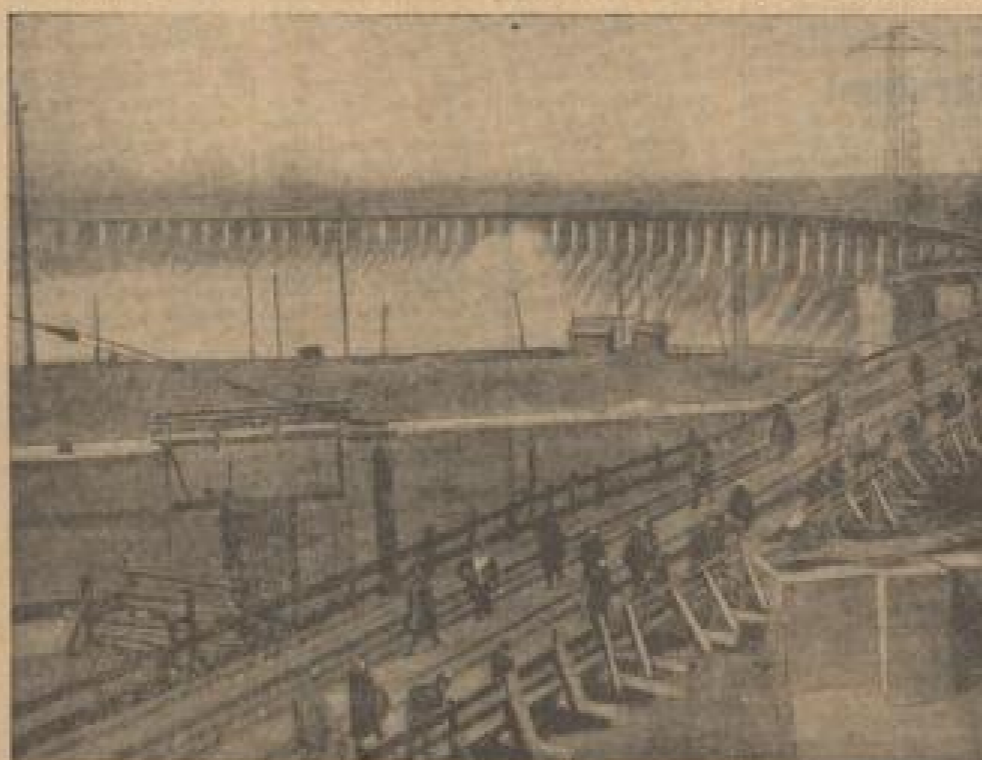
Der riesige Staudamm des russischen Kraftwerkes Dneprostroj, das jetzt in Betrieb genommen wurde. Das Kraftwerk, das der Staat des russischen Dneprostroj gebaut hat, wurde unter Leitung deutscher Ingenieure erbaut. Mit seiner Kraftleistung von 200.000 PS leistet es die Produktion von 400 km. Elektrische Energie selbst gegenüber Kraftwerke hat geplant.
