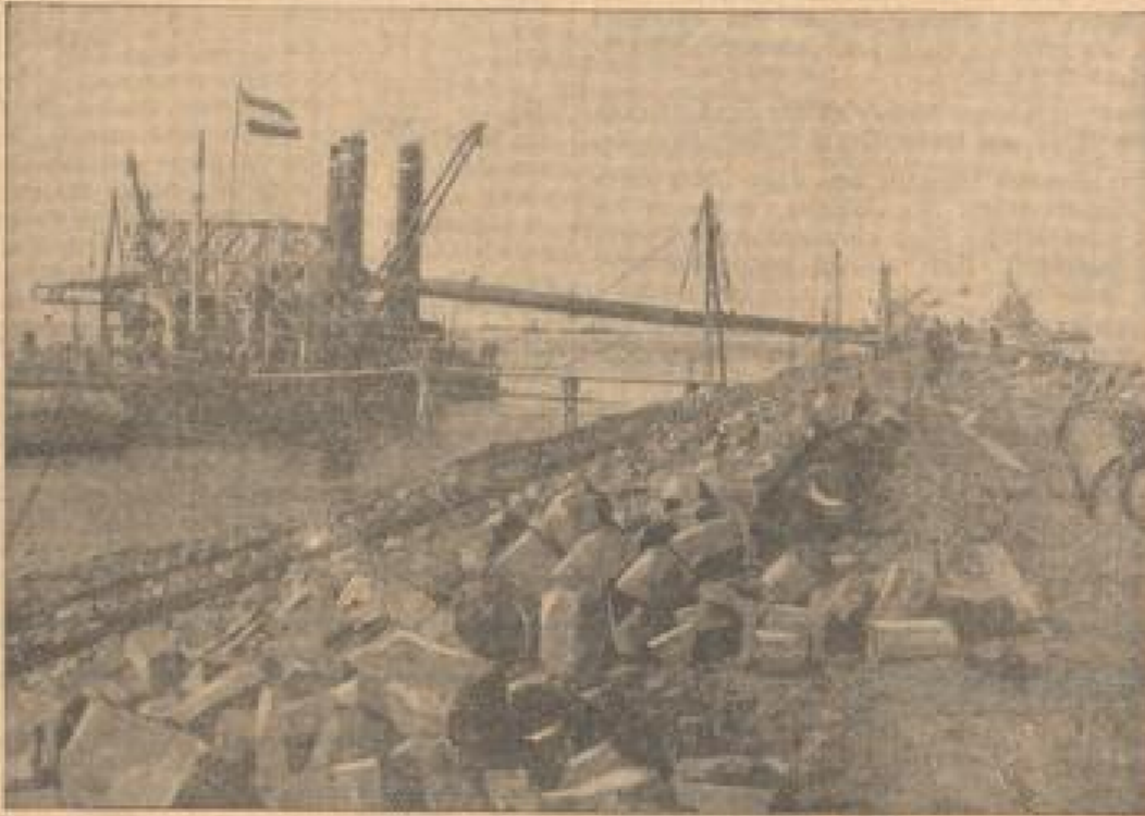
Der Damm vor die Zundersee vom Meer abtrennen soll. Er liegt nach zahlreichen Arbeiten fertiggestellt werden. Damit hat sich die Zundersee in ein Winterquartier verwandelt, das auf große Stürme hin trockengelegt und der Seefahrt abgeschlossen werden soll.
