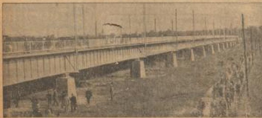
Die neue Dresdener Schladachbrücke, die mit ihrer Länge von 315 Metern die größte von Europa ist, bei der statt der Nieten zur Verbindung der Pfeilerstücke nur elektrische Schweißung angewandt wurde. Die dadurch erzielte Gewichtseinsparung betrug etwa 15 Prozent.
