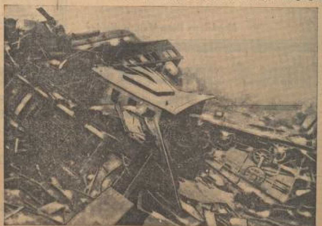
Die Unglücksstätte mit den blig zertrümmerten Wagen, die über einem unterirdischen Tunnel in eine Schlucht bei Klemm (Frankfurt) stürzten. Bei der Katastrophe wurden 20 Fremdenlegionäre getötet und mehr als 200 schwer verletzt.
