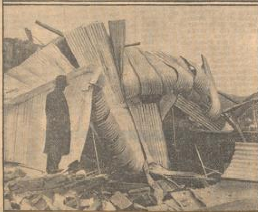
Oben: Die neue Versteckstraße in Waikanae, die durch das neue Erdbeben zum Einsturz gebracht wurde. Unten: Ein Strohstopp, dessen Mauer durch das Erdbeben umgestürzt und zusammengefallen wurde.
