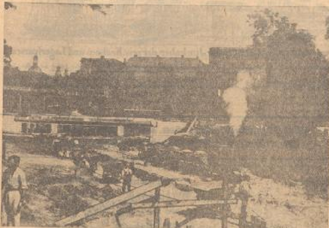
Die Schloßgarten-Unterführung während des Baus
