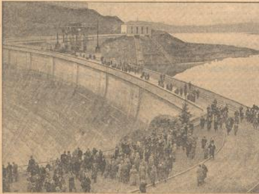
Blick auf den 65 Meter hohen Staubbamm
