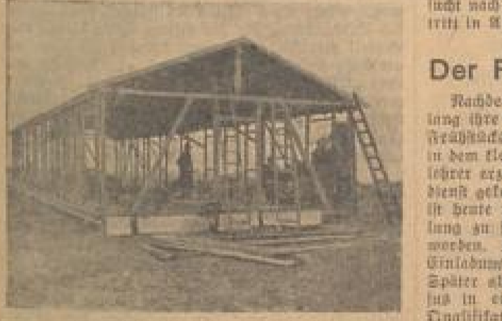
Barracks für 40 Mann im Sandlauer Bruch
