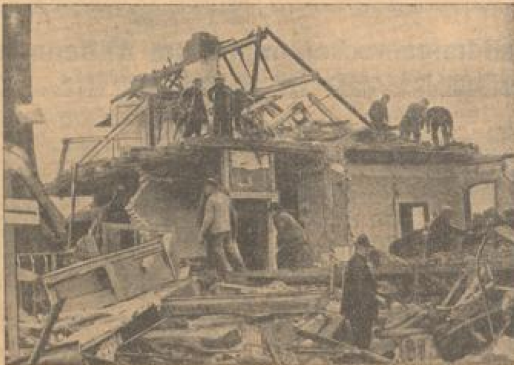
Wohnhäuser der Bonifacius-Straße Neunkirchen liegen nach den Grubenkollapsen bis wegzugehen nach verfallenen Gumbelholzungsgeländebänken.
