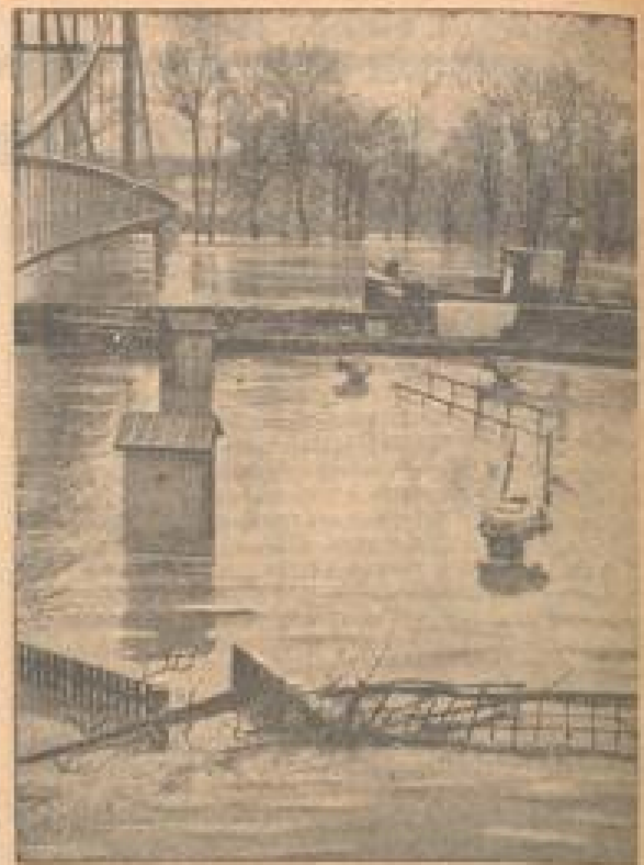
Eine überschwemmte Straße bei Oppeln
