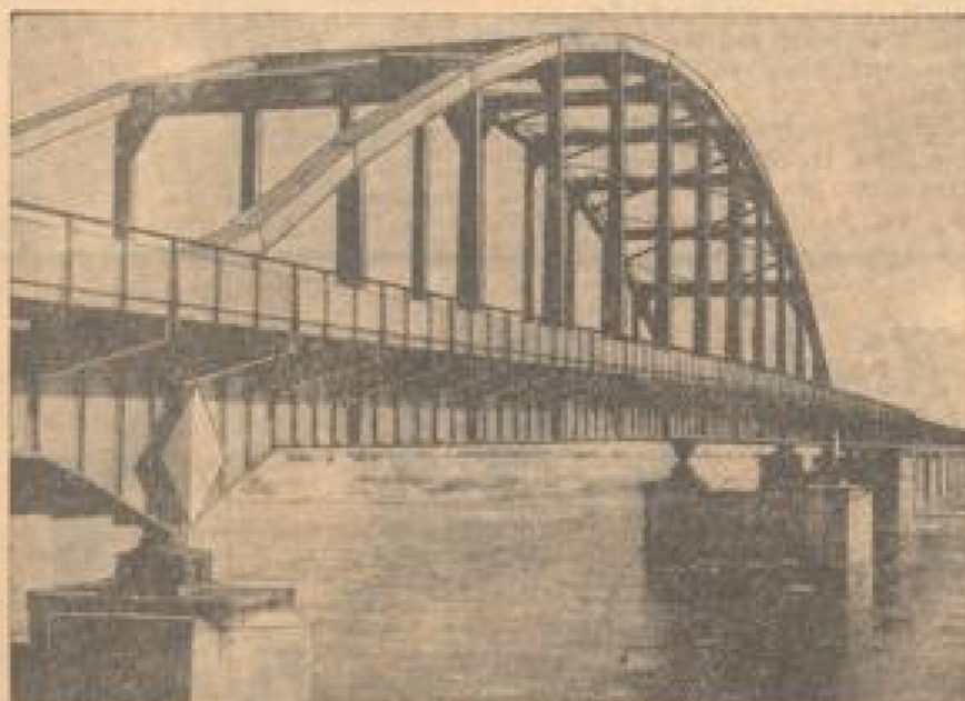
Die neue Elbbrücke, die jetzt nahezu fertiggestellt ist, ist eine der längsten Stahlgeländerbrücken und ist über 1 km lang.
