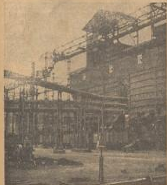
Vom Ofen zum Apparathaus ziehen Gasrohre
