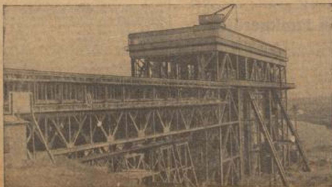
Das Schiffahrts-Gebäude bei Niederfinow (Brandenburg)
