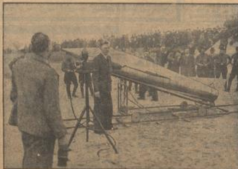
Der Ingenieur Gerhard Jucker vor dem unglücklichen Start seiner drei Meter langen Aluminium-Kiste.
