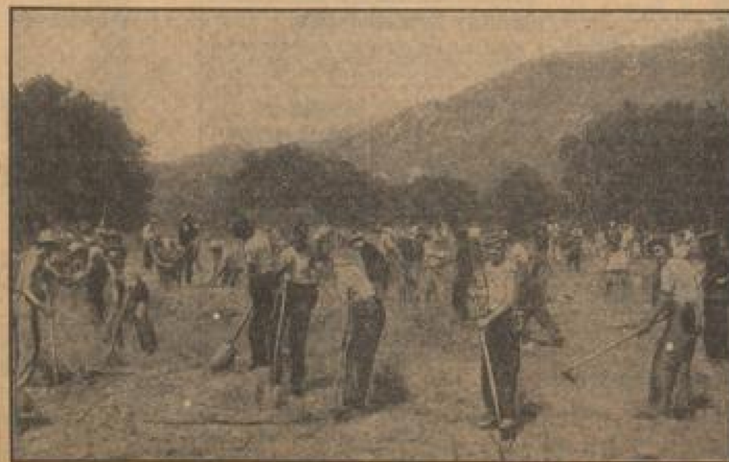
Arbeitsdienstreitwillige beim Straßenbau in Kalifornien
