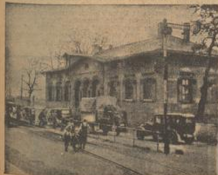
Vor der Brücke steht sich der Verkehr
