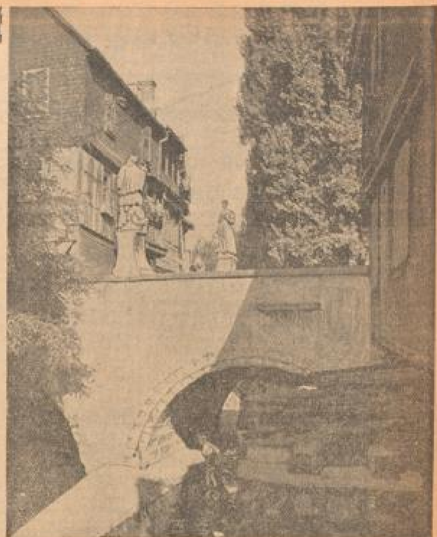
Malerische Brücke in Bensheim
