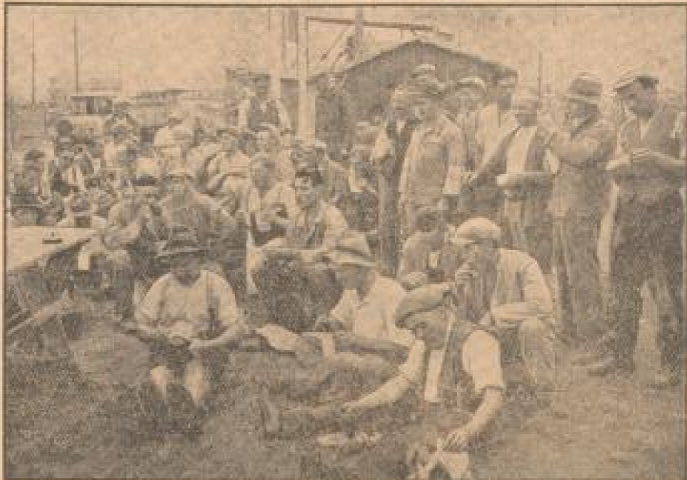
Mittagspause auf der Baustelle
