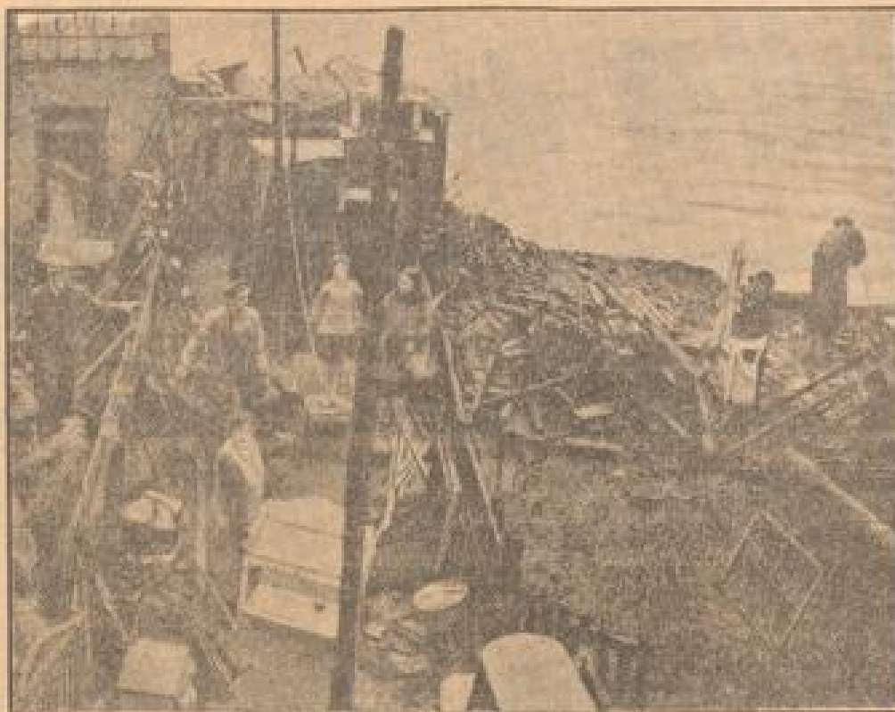
Die schweren Stürme, die in der letzten Zeit das ganze Nordseegebiet heimsuchten, haben vor allem an der englischen Küste schwere Schäden angerichtet. So wurden Teile des Ortes Port Harcourt zerstört. In der oberen Bildhälfte sind die Trümmer einiger Häuser zu sehen, die unter dem Meeresspiegel stehen.
