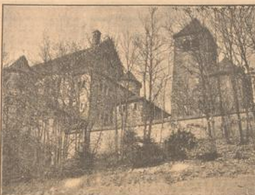
Die Wachenburg, deren Auto-Anfahrtsstraße vollendet wurde
