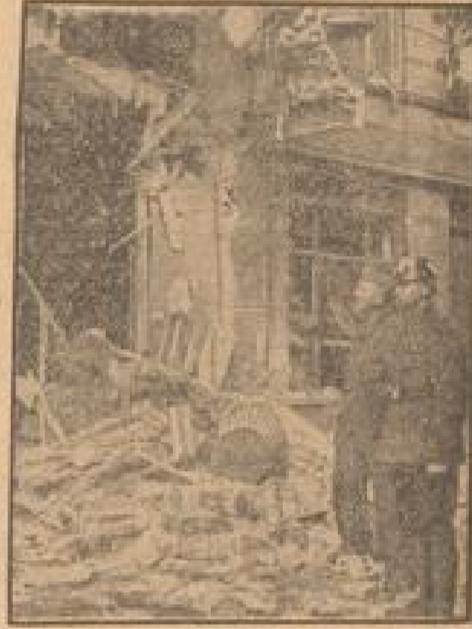
Der Handlungsengang eines Berliner Wohnhauses wurde durch eine Sprengbombe zerstört
