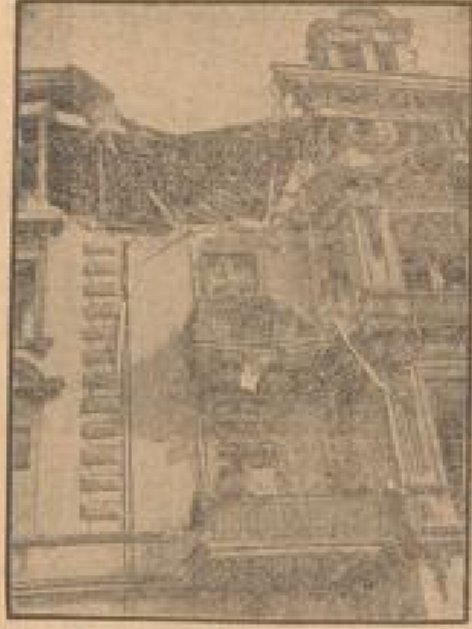
Ein durch britischen Bombenwurf beschädigtes Berliner Wohnhaus
