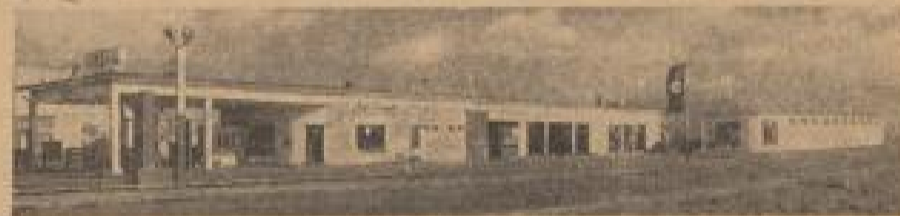
Die Betriebsanlage der Firma Auto-Schmitt Käfertal
