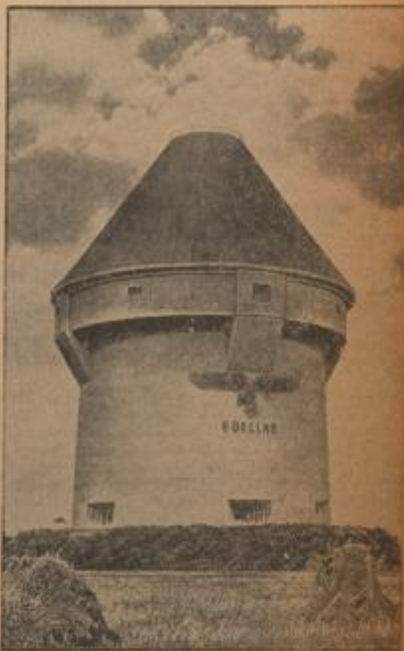
Luftverteidigungszone West Ein Luftschutzsicherungsgebäude, das bis zu 3000 Personen Schutz gegen Bombenangriffe gewährt. (Foto: Hoffmann, Sonder-Multispez.-R.)
