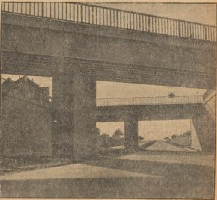
Schönheit der Technik! Zwei gewaltige Betonbrücken überspannen die Reichsautobahn
