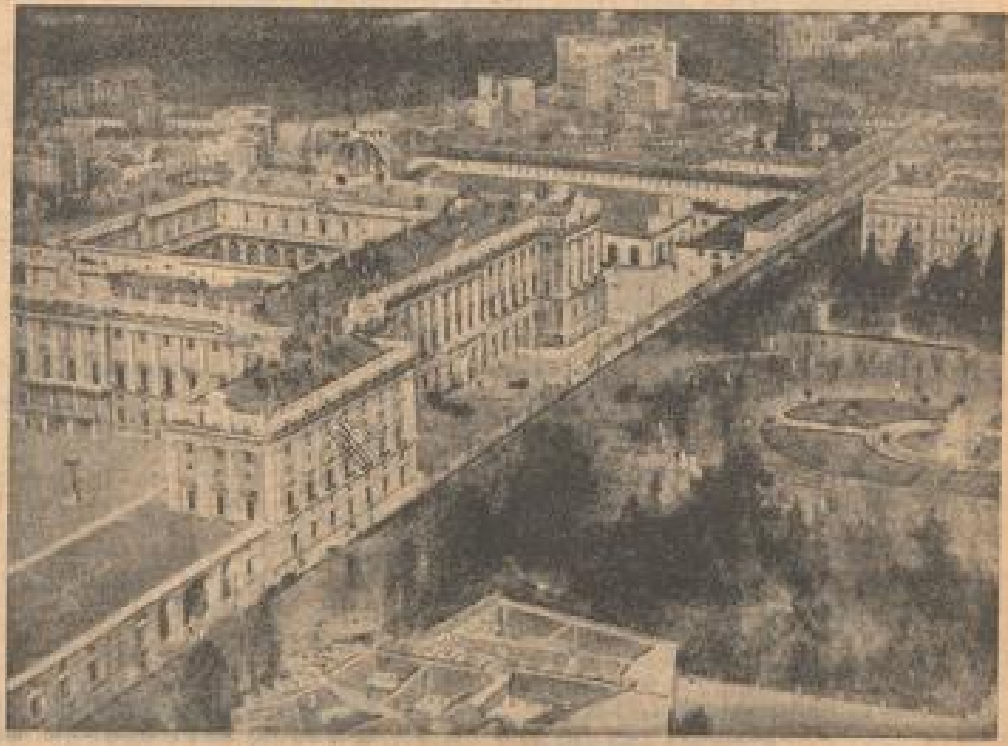
Spanische Hauptstadt Madrid, die sich im Zentrum der Halbinsel befindet.
