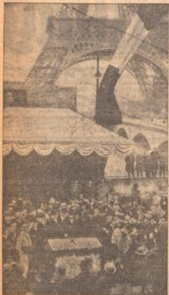
Auf dem Aufstellungsgelände an der Seine gegenüber dem Eiffelturm (und die feierliche Grundsteinlegung für das „Deutsche Haus“ der Weltausstellung 1937) mit dem ehemaligen Reichspräsidenten Dr. Brüning (links) und dem französischen Handelsminister Dabry (rechts).
