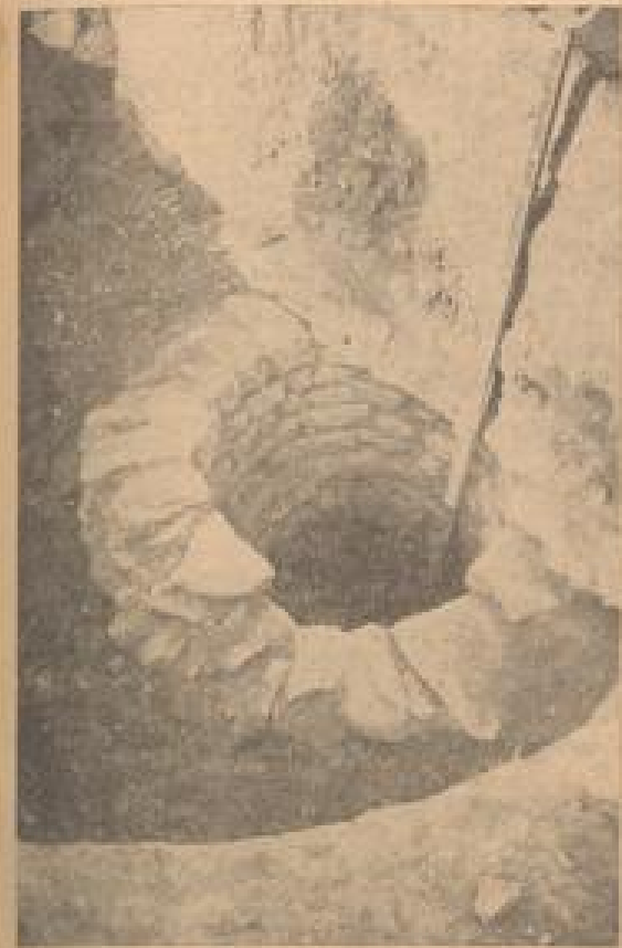
Alt-Hermsheims Brunnenanlage wurde bei Ausgrabungsarbeiten des Schlossmuseums vorgefunden
