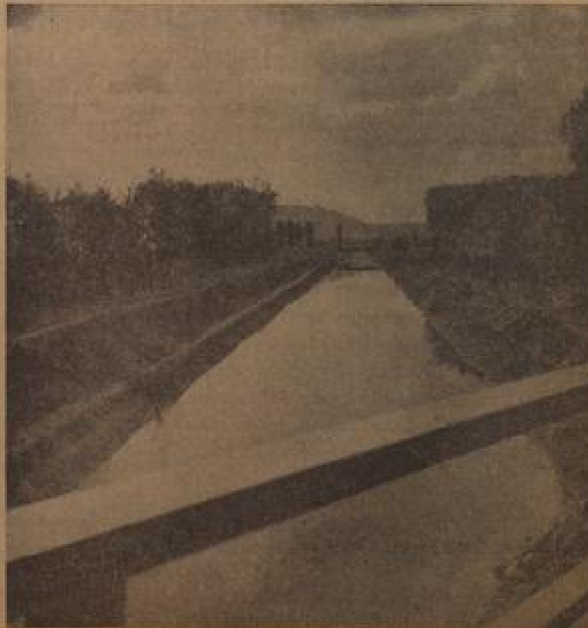
Hier: Der 1600er Deckelbau von der Autobahn über den großen Flugs-Entlastungskanal auf Durlach mit seinem Turmberg.
