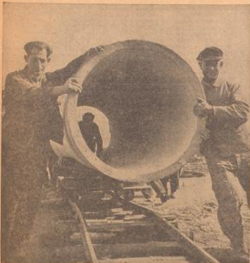
Grundwasser und Wassergrube erforderliche besondere Vorkehrungen der Straßenbauer. Ein Entwässerungsgraben zum Einbau des Pfeilers.
