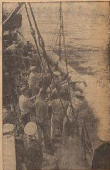
Wenn er ausgelautet ist, hebt ein kleiner Kran den rauhenden Torpedo an Bord
