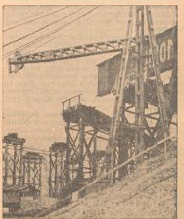
So sieht es an einer Baustelle aus
