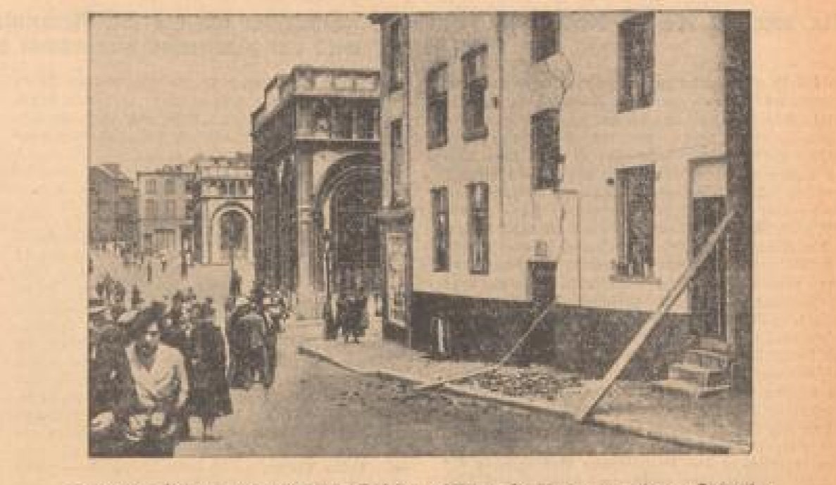
Diese Teile Belgiens wurden durch ein Erdbeben erschüttert. Die Schäden an den Gebäuden sind beträchtlich. Hier eine Aufnahme aus Brüssel, und viele Städte umliegender Provinzen sind ebenfalls betroffen. (Foto: H. J. G. - Central, London-Multiplex-R.)
