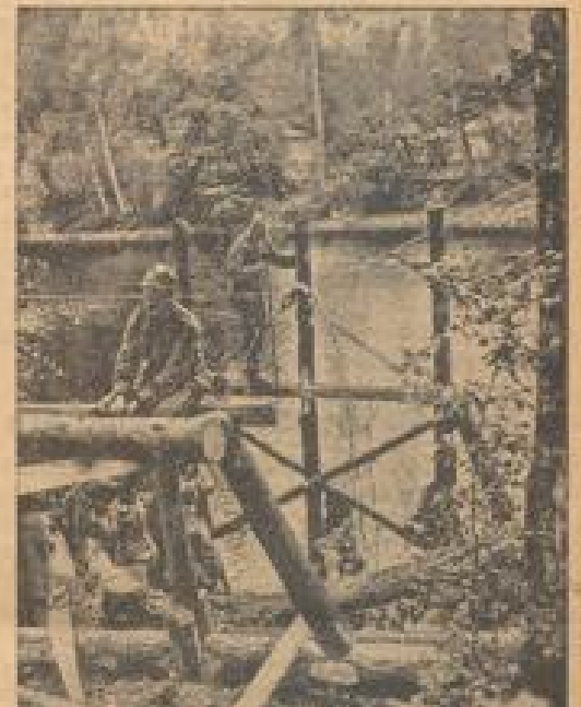
Schwedische Pioniere bauen eine Holzbrücke
