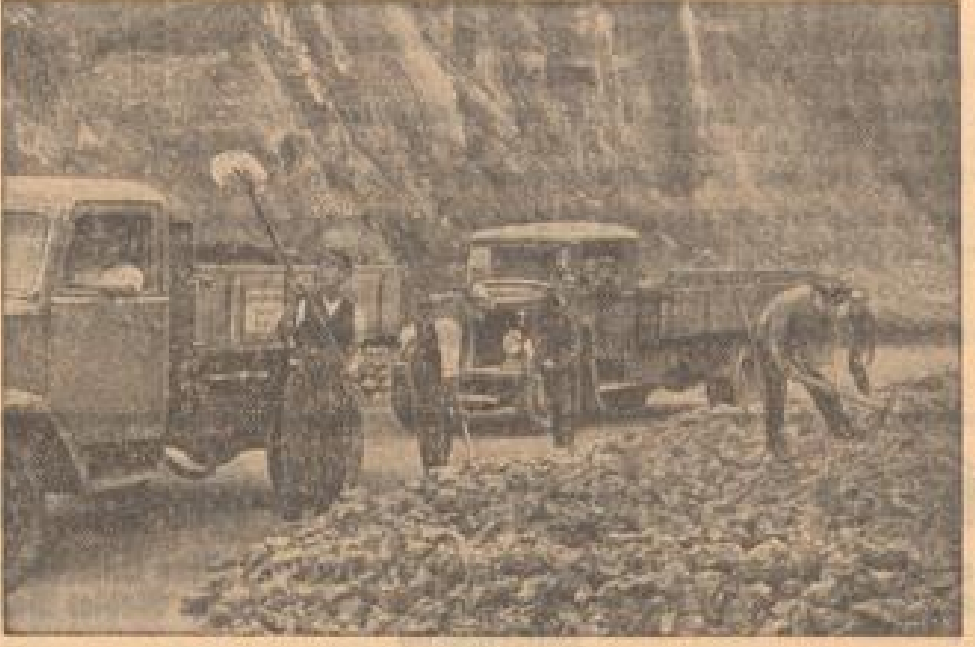
Befestigungen, die Deutschlands Westgrenze schützen Tausende von Volksgenossen haben bei den Befestigungsarbeiten an Deutschlands Westgrenze beigetragen.
