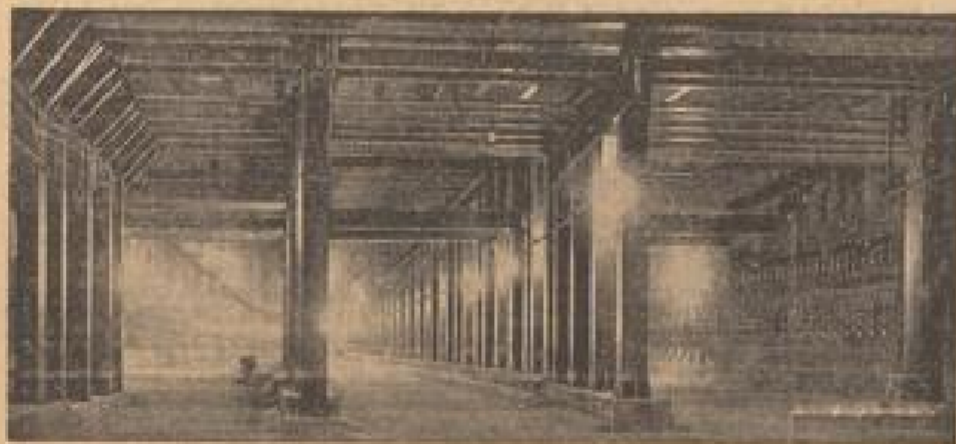
Neues unterirdisches Berlin Ein Bild in den technologischen Tunnel am Stadtbahnhof, Berliner Hauptbahnhof. Der unterirdische Tunnel in der Mitte dient als Abfahrbahn. Links: Eine Hochzeitstorte aus 300 Garmeleisen Die Kaiserin möchte man in U.S.A. zur Schenkungsfähigkeit. Sie trägt eine Hochzeitstorte, die 3000 Teller hat. Rechts: Neues Gesicht im deutschen Film Ruth Selberg, eine normale Schönheit, die im Neuen „Brause“ für Götter „G.I.“ spielt. (Photo: U.S.)
