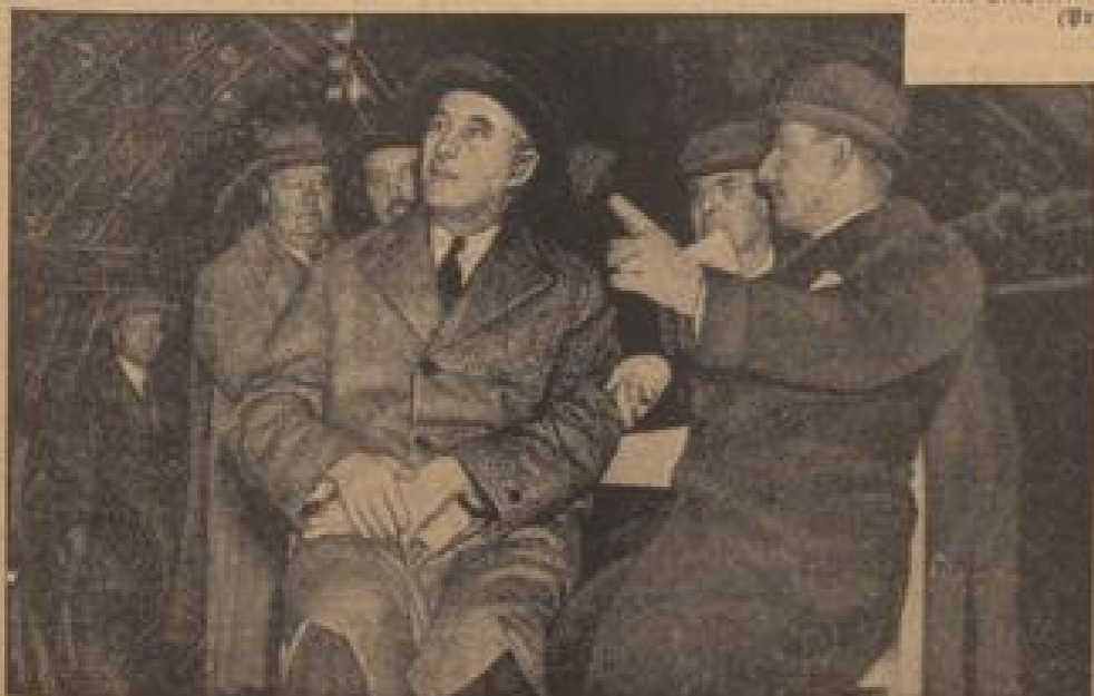
Der Verkehrsminister fährt durch den Probetunnel unter der Themse In London wurde jetzt ein betriebsfertiger und hoher Probetunnel unter der Themse vollendet, der als Vorbild für einen geplanten neuen Tunnel zu Dover zu Dover eine Gesamtlänge von 1000 Metern haben wird. Der englische Verkehrsminister Neville Chamberlain hat einen Probefahrt in dem Probetunnel, dem sogenannten Dartford-Dartford Tunnel. (Associated Press, Sonder-Dr.)
