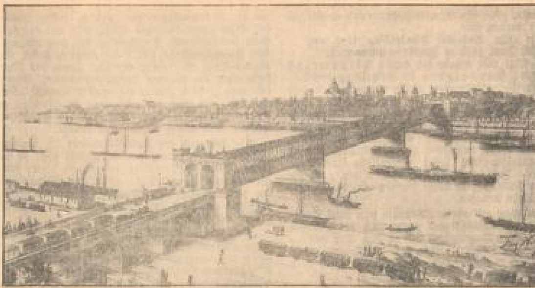
Die Rheinbrücke in ihrem ursprünglichen Zustand
