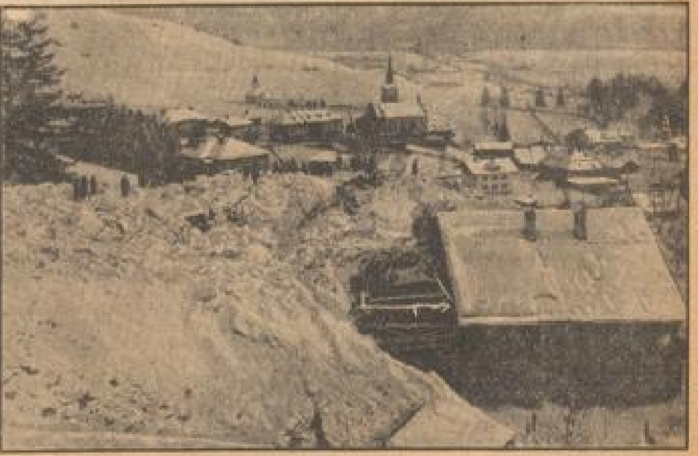
Nach dem Lawineneingriff von Mühlau in Tirol. Die tiefe Längs-, bis auf Mühlau in einem Sandstein überhängend und auf ihrem Wege eine Reihe von Schneehaufen, Ställen und Scheunen zerstört.
