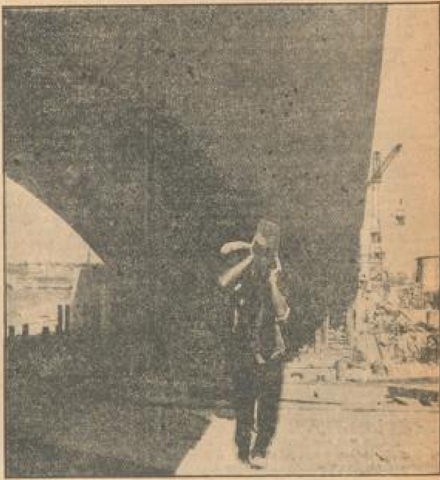
Schönheit der Technik: Licht und Schatten in einem Pfeilerbogen der Seckheimer Neckarbrücke. Photo: M. Schöcher
