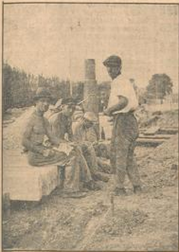
Mittagspause beim Montieren der Lichtmasten an der Rhein-Neckar-Halle
