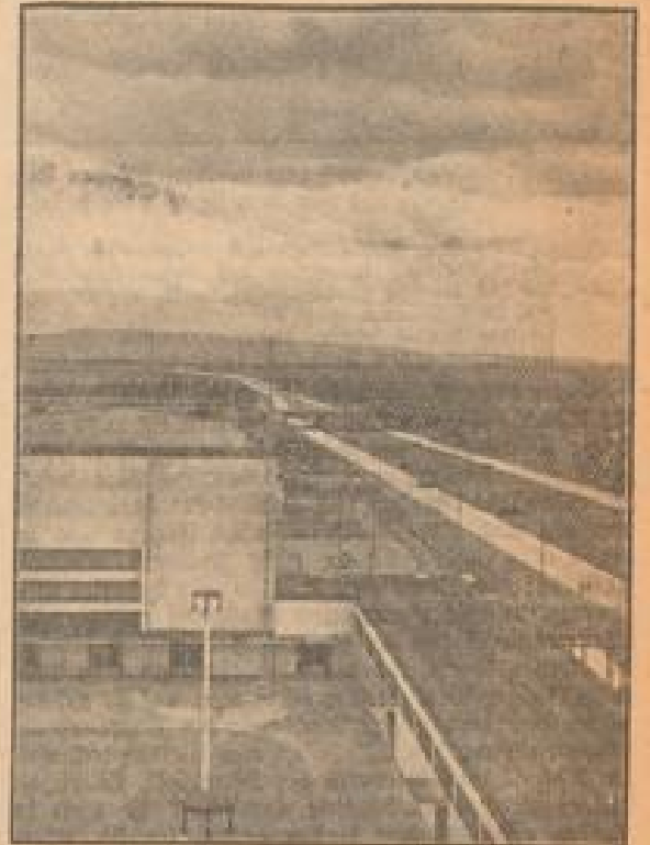
Von besonderem Reiz ist ein Blick von der „Laternen“ der Rhein-Neckar-Hallen auf die weit ins Land schießende Reichsautobahn
