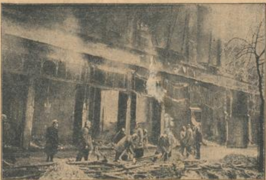
Der Riesenbrand des Warenhauses Tietz in Berlin. Deutsche Presse-Photo-Zentrale, Berlin
