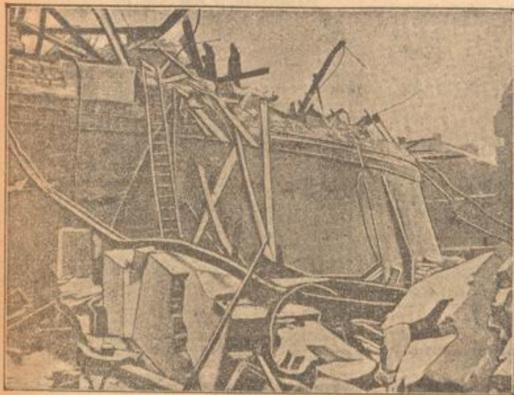
Die verbogenen Eisenhülle und Mauerreste des Gasometers zeigen die Verheerungen der Gasexplosion.
