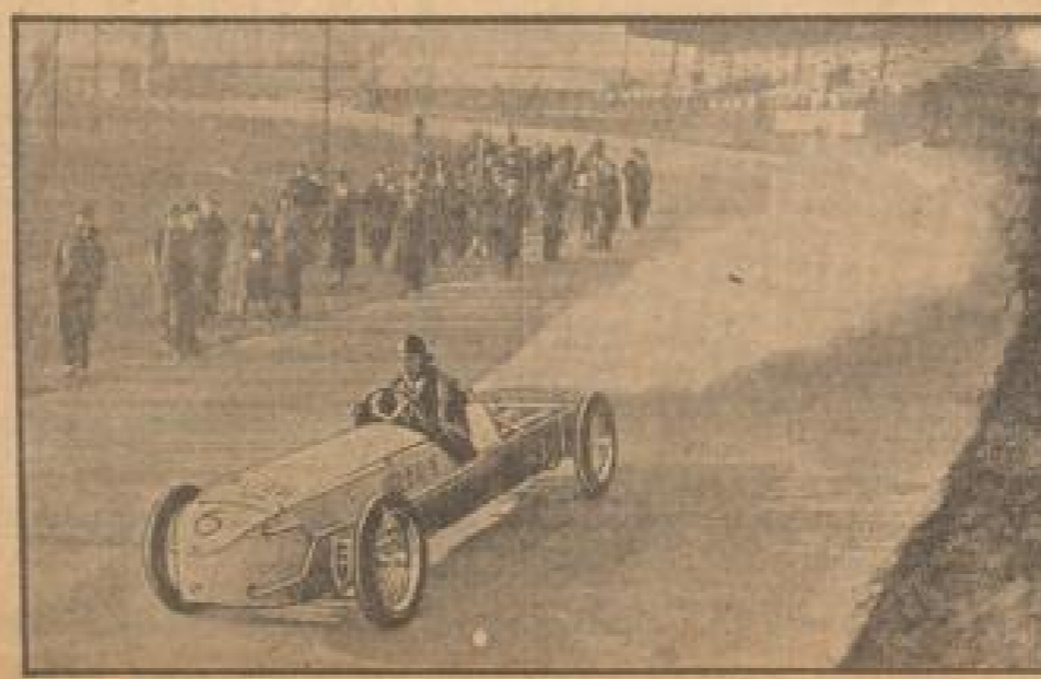
Waf der Berliner Kunst-Maler Augusten-Walter seinen neuen Rückstoßwagen vor, bei dem nicht mehr Motoren, sondern die weniger gefährliche Komprimierte Luft als Antriebsmittel dient. Das letzte Rad ist mit einem Ventil versehen; die Rückstoßkraft wird durch dieses Ventil erzeugt und bewirkt beim Ausfahren des Autos den Antrieb.
