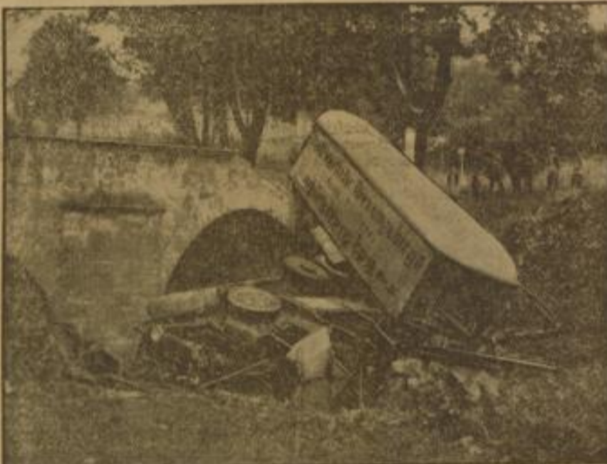
Möbeltransport-Lastzug stürzt in den Abgrund. — Ein Toter, vier Schwerverletzte. Ein folgenschweres Verkehrsunfall ereignete sich bei Altschönan an der Rabach. Ein vollbeladener Möbeltransportzug stürzte an einer Kurve über das kleinere Brückengeländer in die Rabach. Die Wagen wurden vollkommen zertrümmert. Ein Beifahrer fand den Tod, während der Führer und drei weitere Mitfahrer schwerverletzt geborgen werden konnten.
