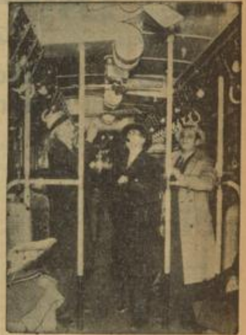
In New York werden umfangreiche Versuche angestellt, mit dem Zweck, den Lärm der Untergrundbahnen auf ein Minimum zu beschränken und damit die Herzen des Großstadtmenschen zu schonen. Unser Bild zeigt einen Versuchswagen mit schalldämpfenden Vorrichtungen an der Decke.
